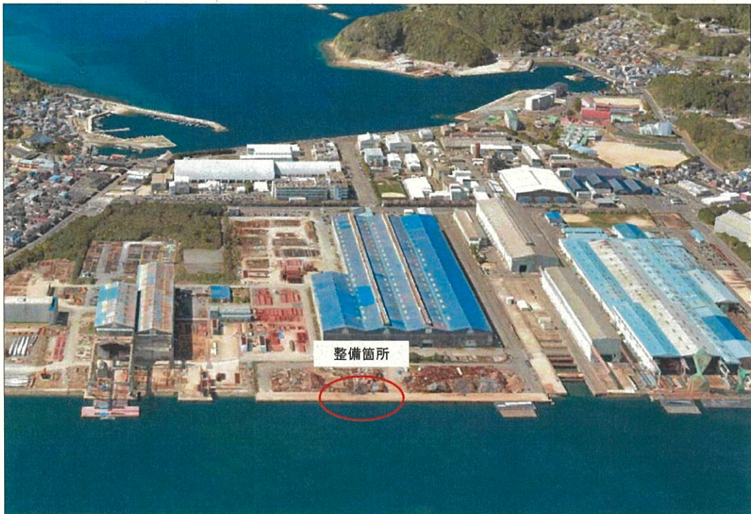
整備箇所全景
