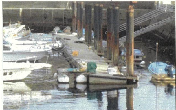
浮棧橋の現状(全景)
