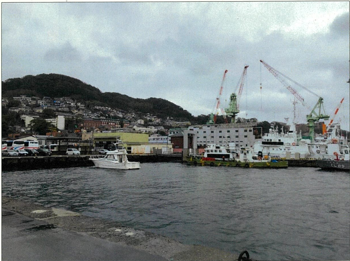
移転補償箇所の現況
