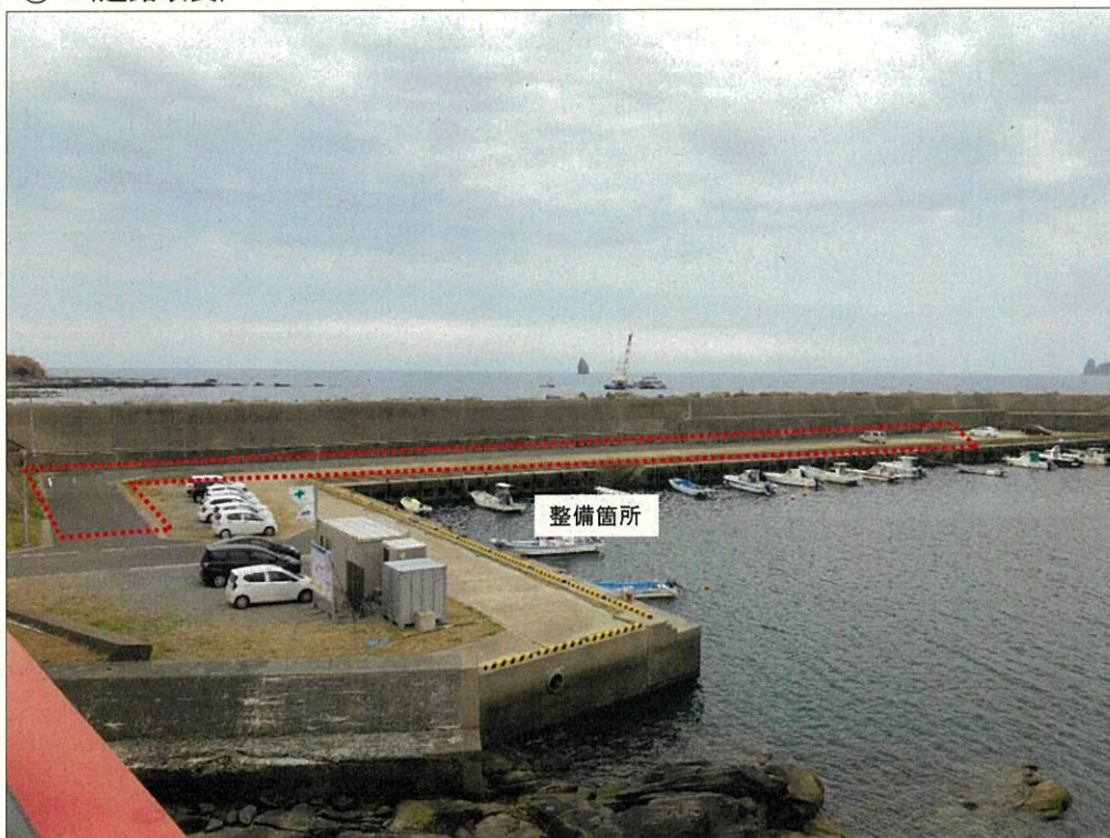
臨港道路の現況
