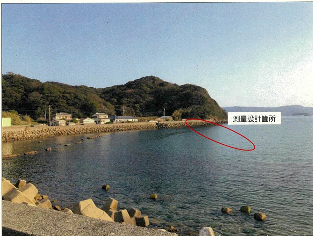
整備箇所全景
