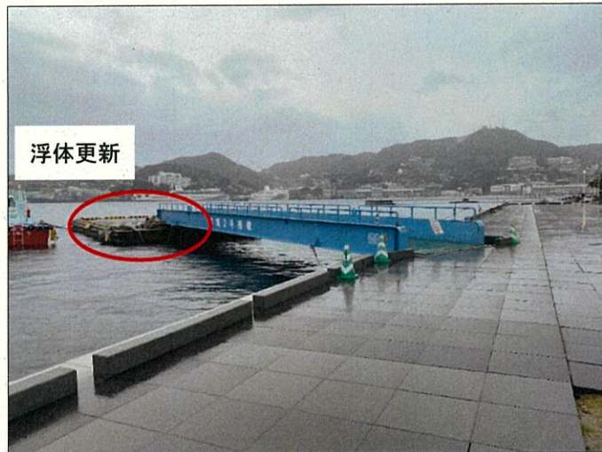
浮棧橋の現況
