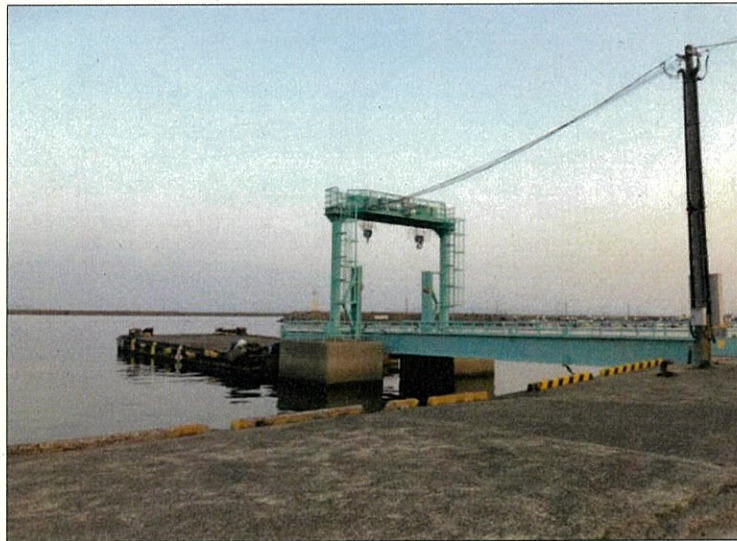
浮棧橋の現況
