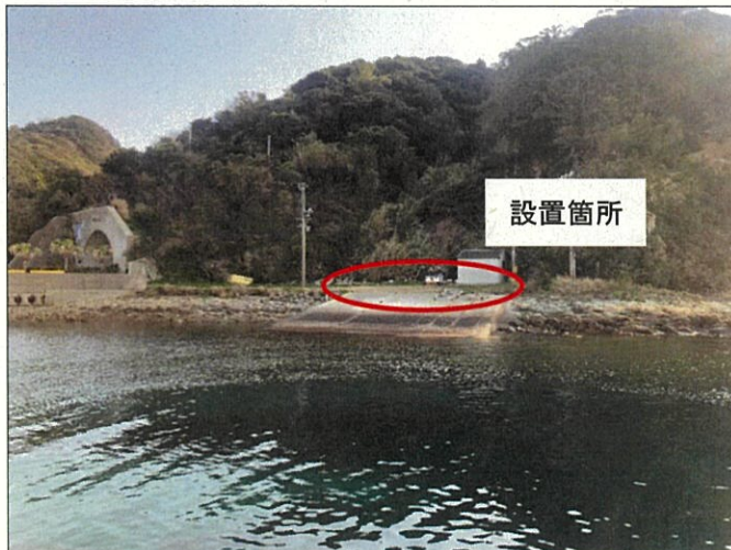
係船環設置箇所の状況
