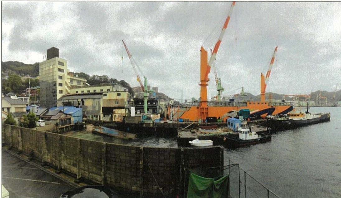
移転補償箇所の現況
