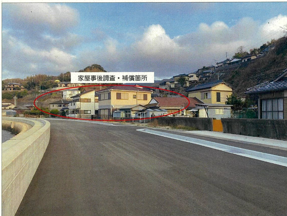
護岸及び市道整備の状況
