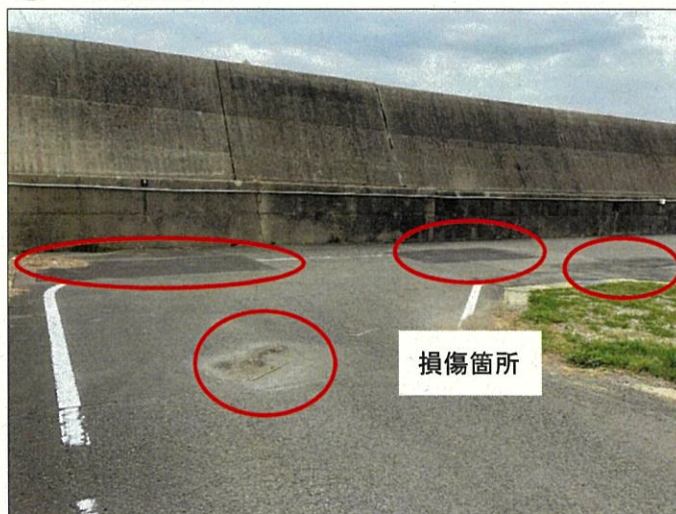
臨港道路の現況
