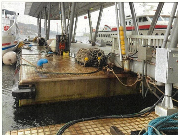
浮棧橋の現況
