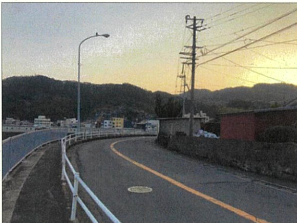
臨港道路の現況
