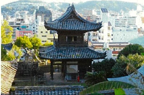
鐘楼（北側面全景）
