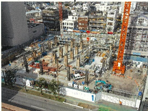
北街区 (1階部分建設中)
