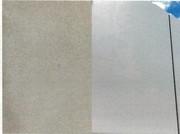
押出成形セメント版:素地仕上げと塗装仕上(25-80A)の2種類
