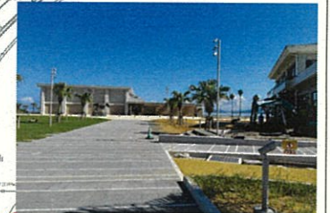
インフォメーションセンター 入口付近
