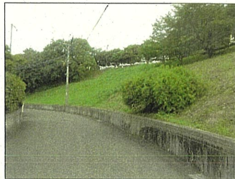
(盛土のり面の状況)
