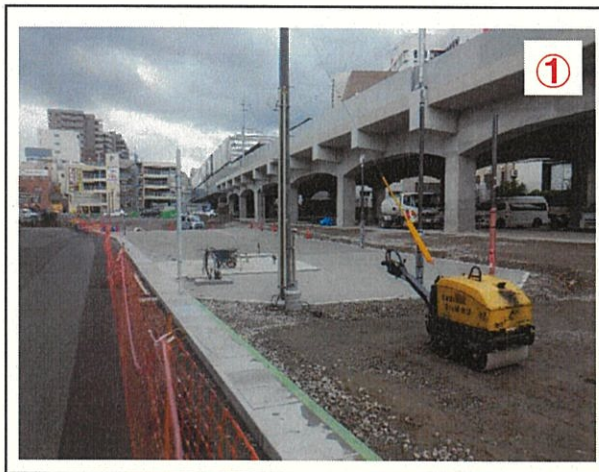
施工状況（令和3年11月撮影）
