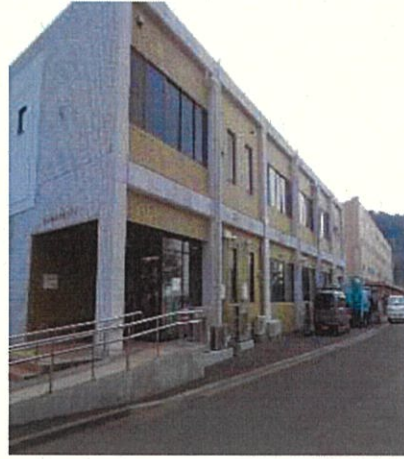
【池島開発総合センターの現況写真】
