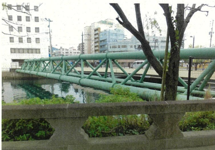
玉江橋水管橋 昭和42年建設 全長 42m φ700×2 本（配水管）
