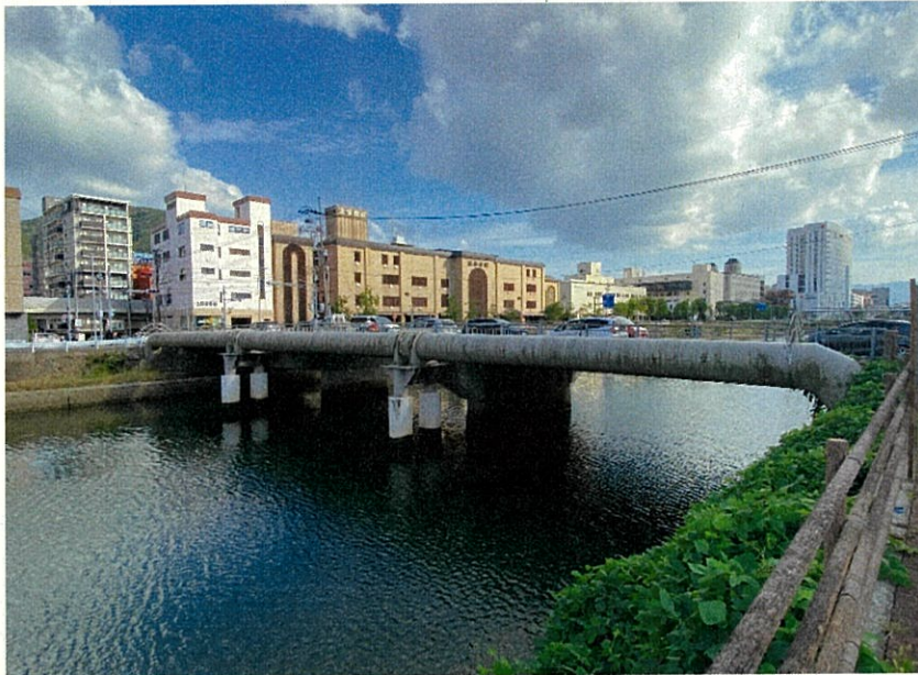
竹岩橋水管橋 昭和 44 年建設 全長 48m (3 径間) φ1200 (配水管)
