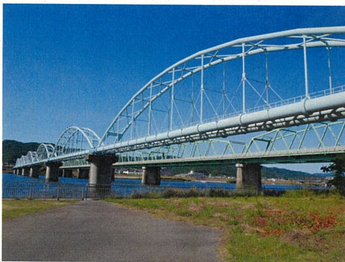
六十谷水管橋 1975（昭和50）年建設 全長 546m（9 径間） φ900×2 本（送水管）
