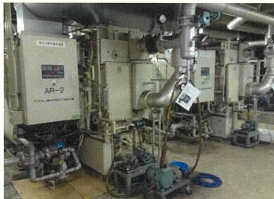
ターミナル改良（空調設備工事）
