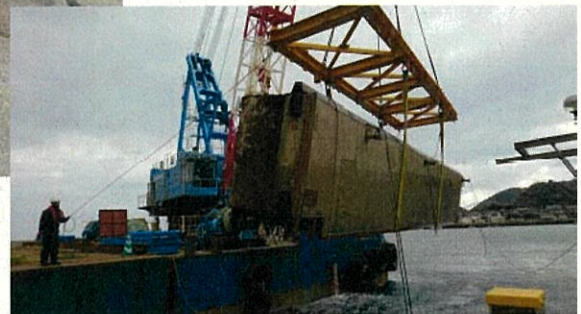
浮棧橋の陸揚げ状況
