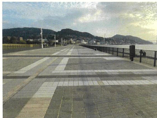
クルーズ船受入環境整備 (Wi-Fi環境整備)
