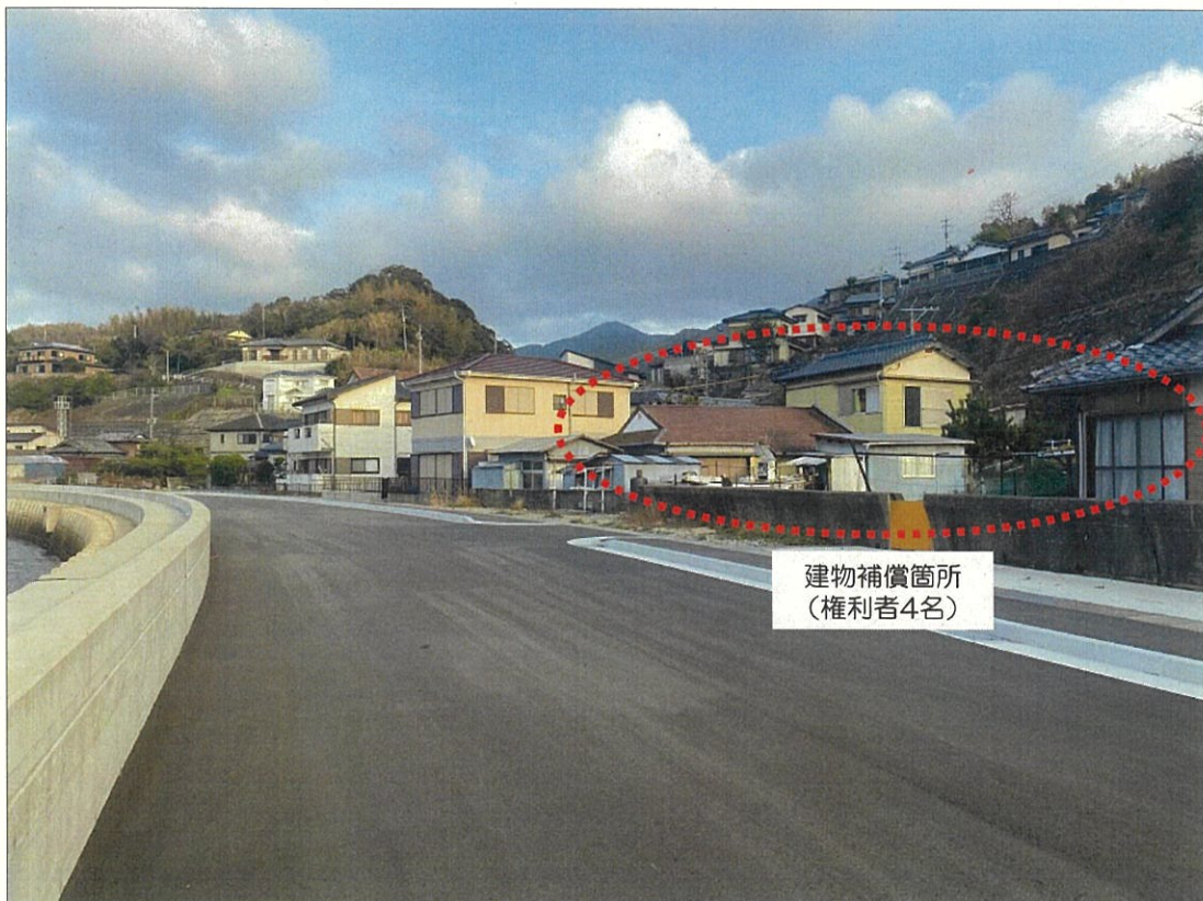
護岸及び市道整備の状況
