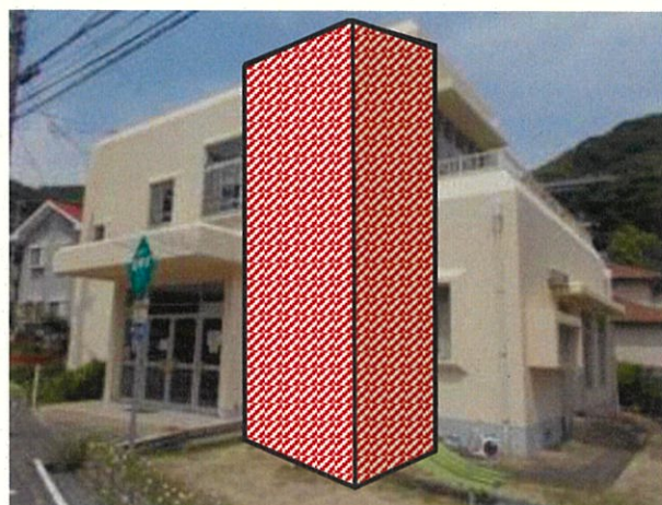
エレベーター設置予定箇所
