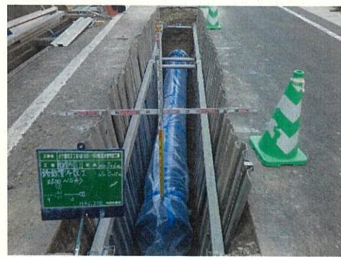
【参考】φ500 配水管 布設状況写真
