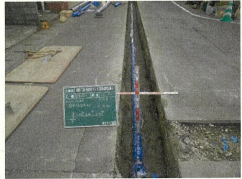
【参考】 \phi 100 配水管 布設状況写真
