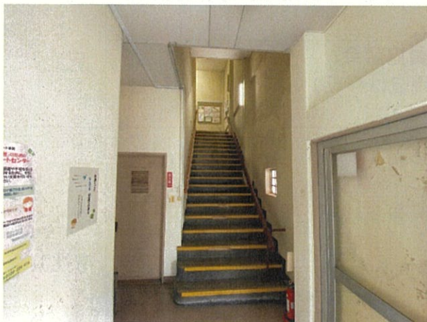
写真3 建物内階段（1階～2階）
