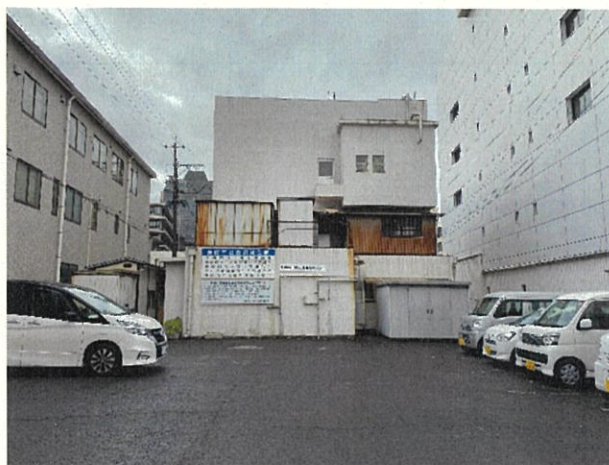
写真2 外観（裏通り側）
