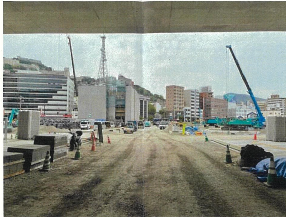
新幹線高架下から国道側 (東側) を望む
