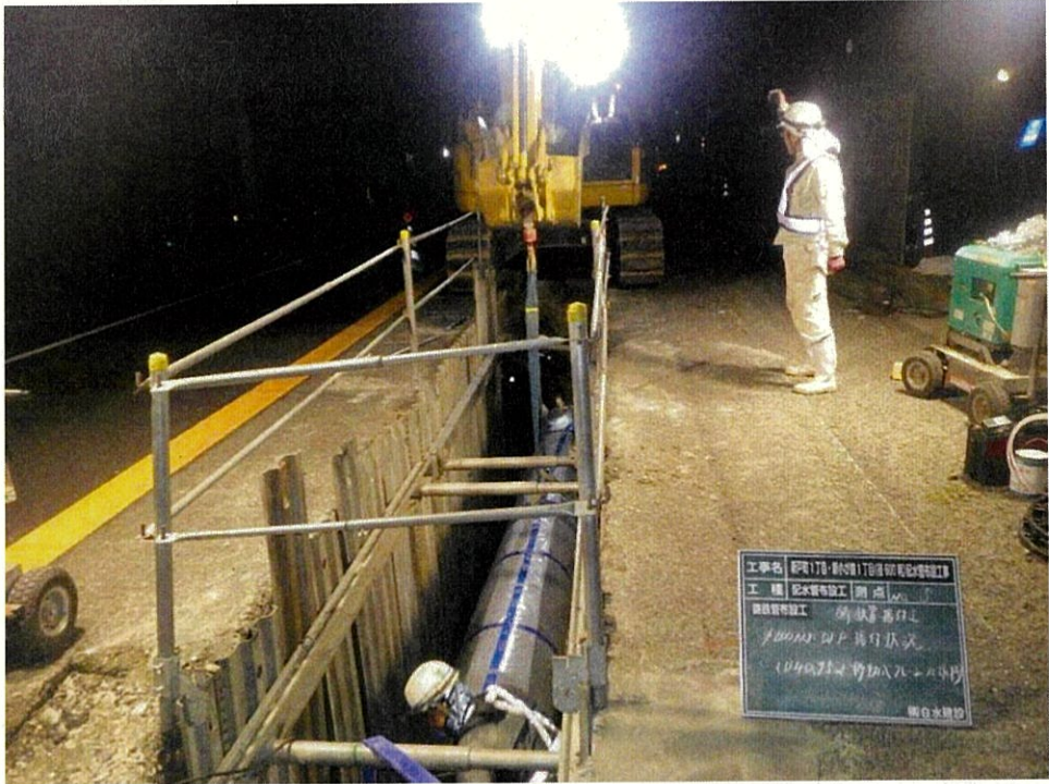
配水管開削布設状況
