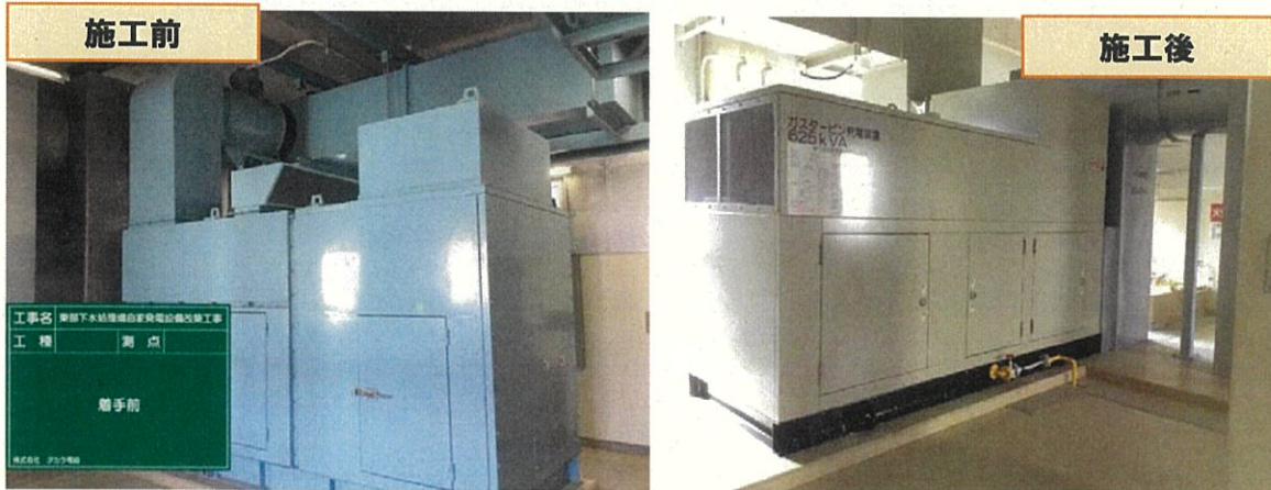
東部下水処理場自家発電設備改築工事
