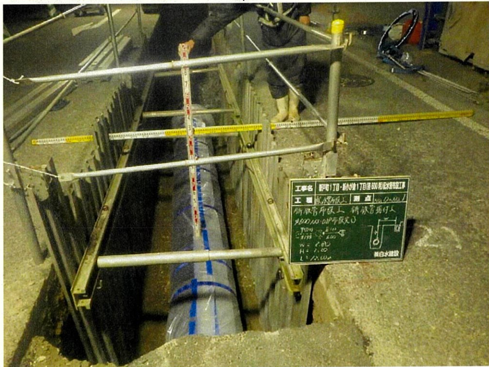
配水管布設完了
