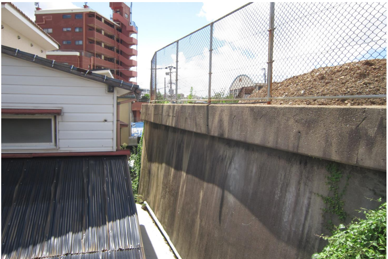
写真②（南側擁壁と隣接家屋）
