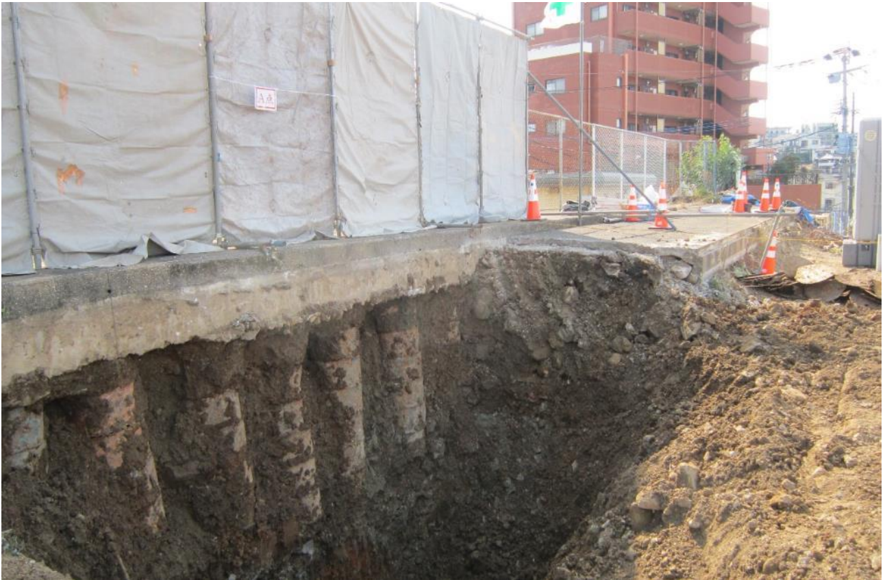
写真①（南側擁壁）
