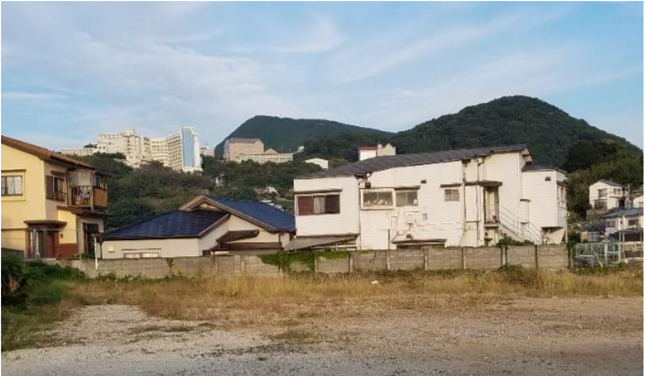
写真③（東側ブロック塀、鉄製フェンス）
