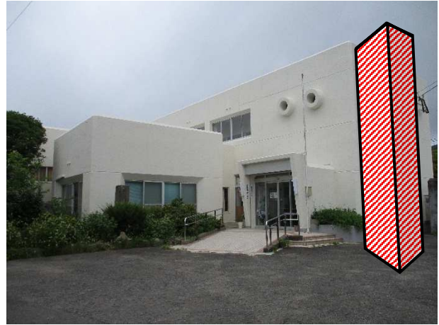
エレベーター設置予定箇所
