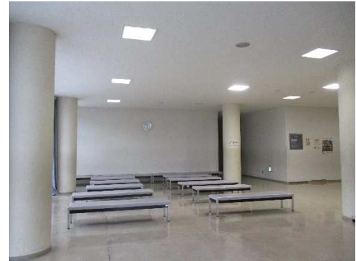
LED施工箇所例(玄関ロビー)
