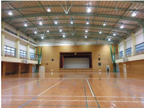
LED施工箇所例(アリーナ)
