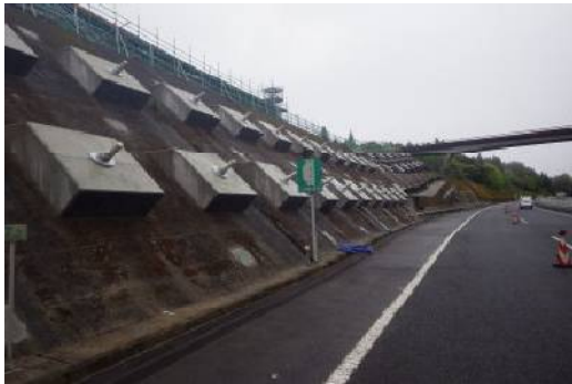
参考写真：グラウンドアンカー工
