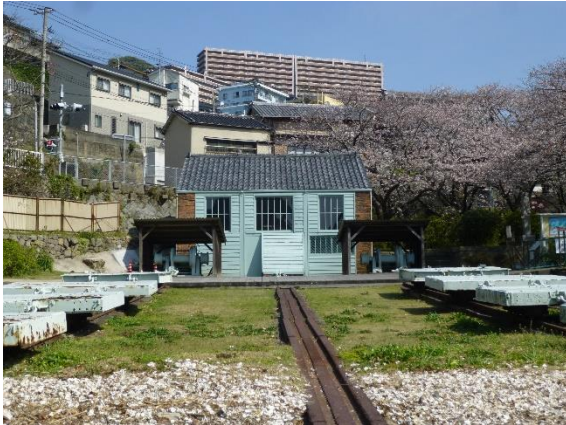
曳揚げ機小屋(正面)
