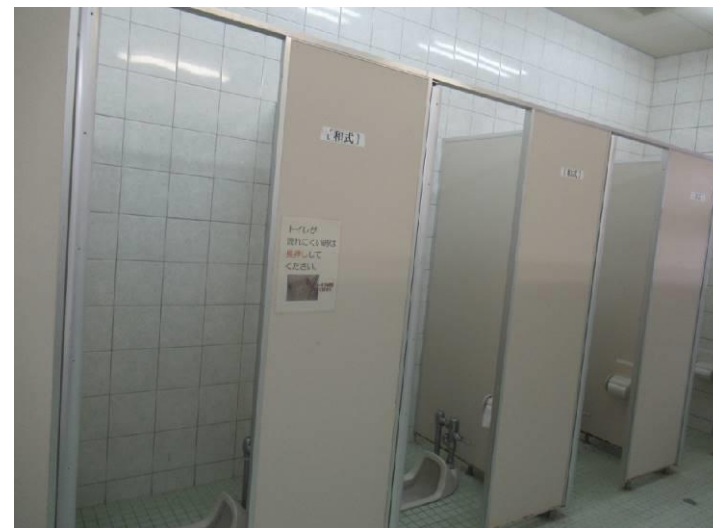
■管理棟トイレ現況写真
