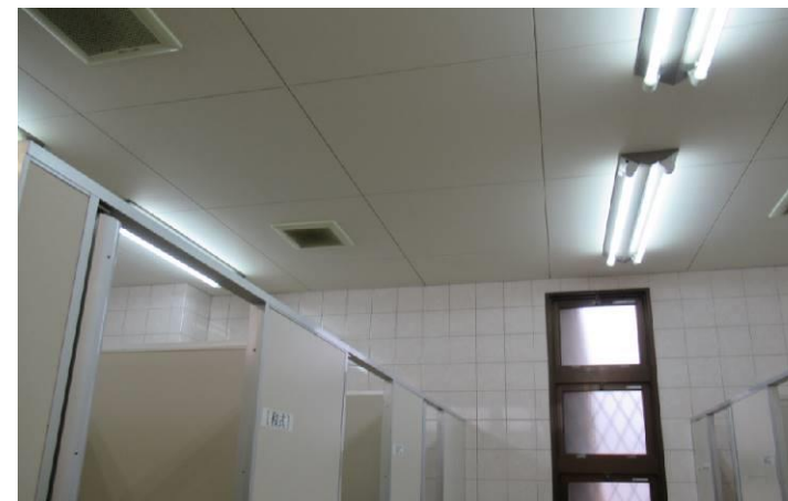
■管理棟トイレ照明現況写真
