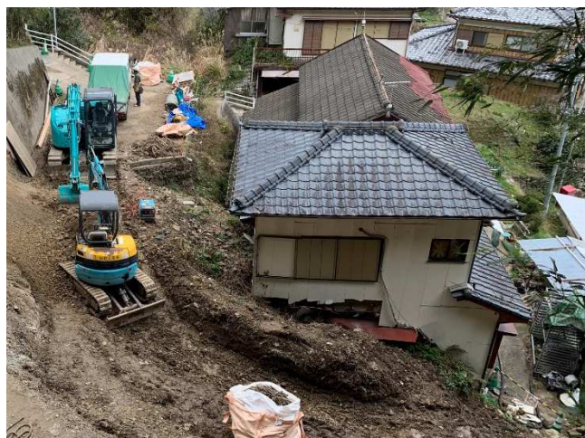
被災家屋状況
