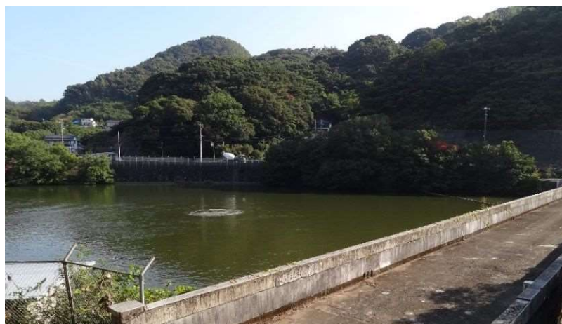
写真 浦上ダム曝気状況（長崎市）
