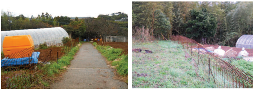
ワイヤーメッシュ柵の設置状況（式見・三重地区）
