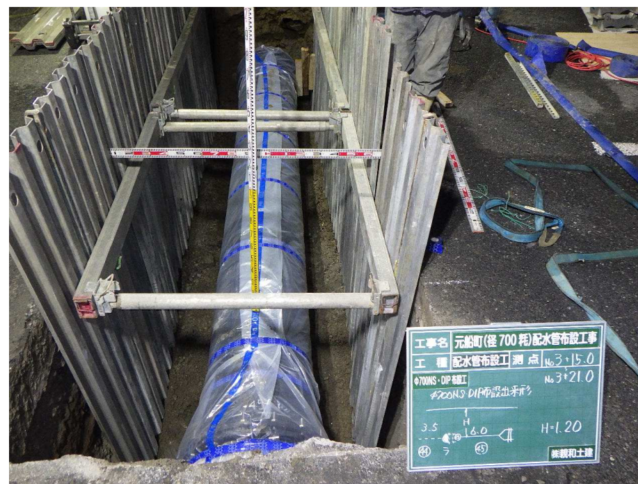
元船町(径700mm)配水管布設工事 φ700mm
