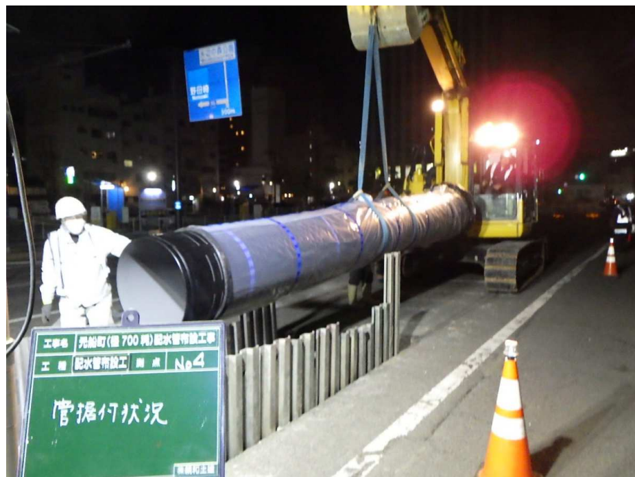
元船町(径700mm)配水管布設工事 φ700mm
