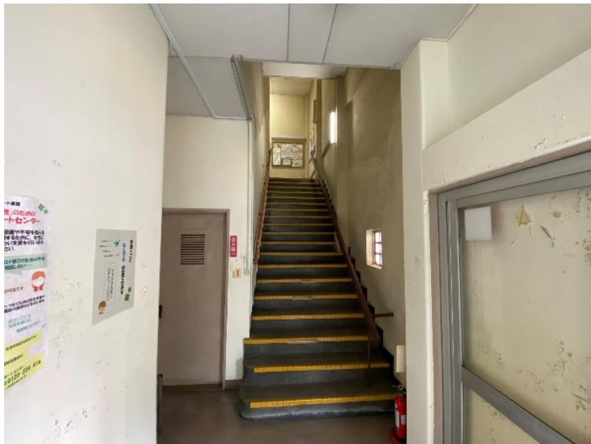
写真3 建物内階段（1階～2階）
