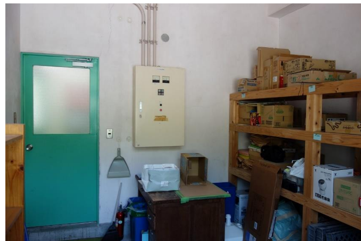
倉庫(旧機械室)
