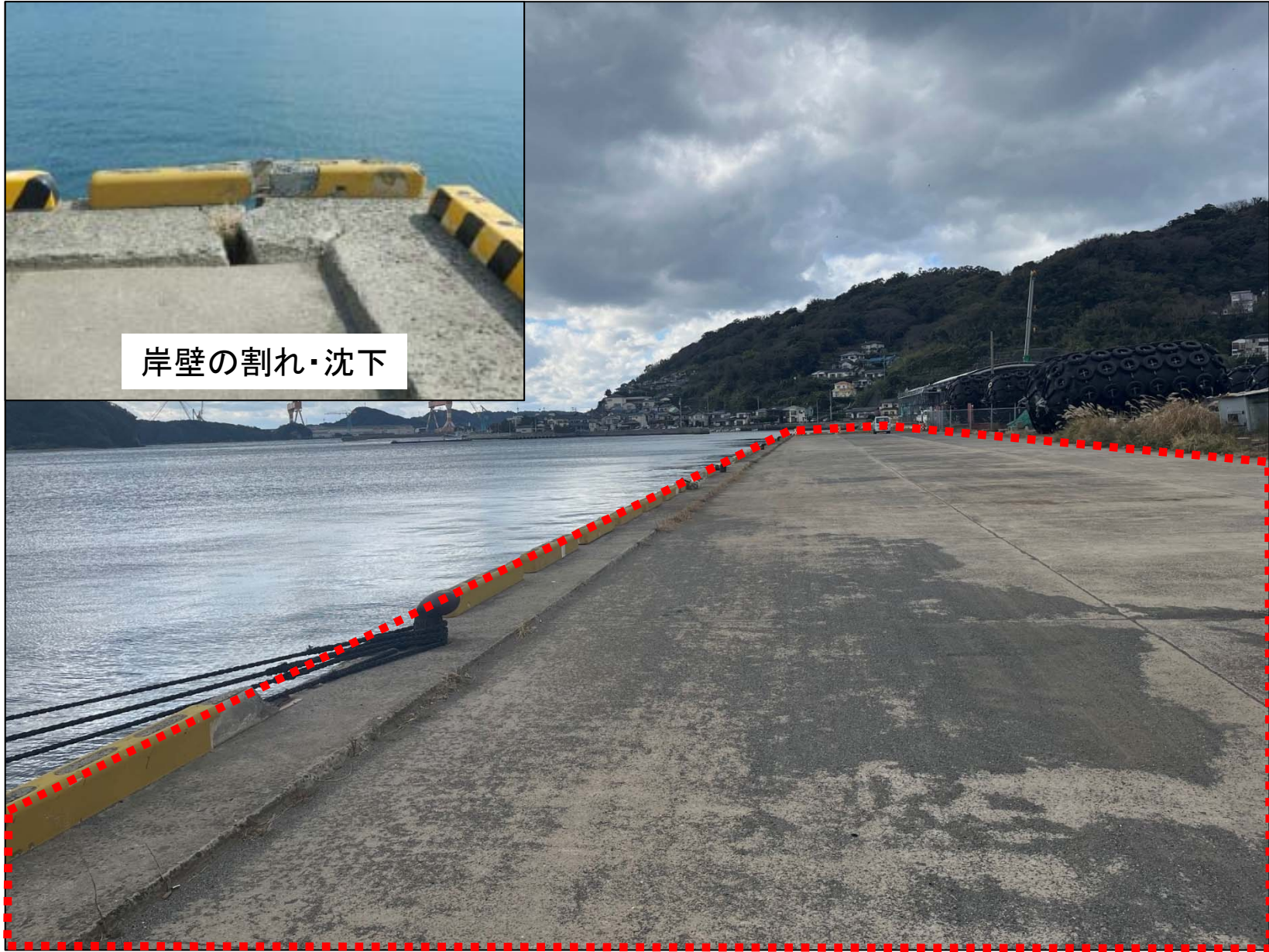
岸壁改良箇所の現況
