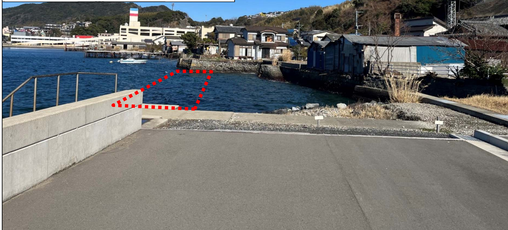
護岸改良箇所(地盤改良)
