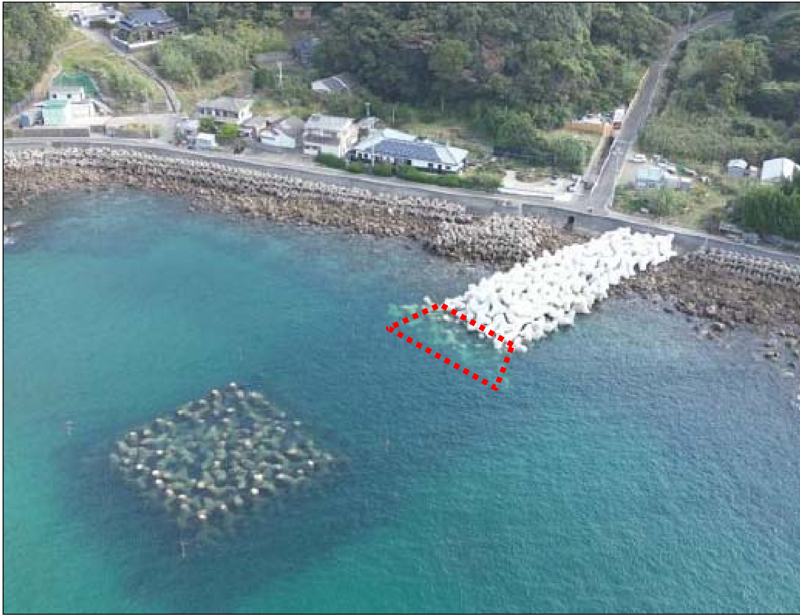
離岸堤新設箇所状況(消波ブロック製作・設置)
