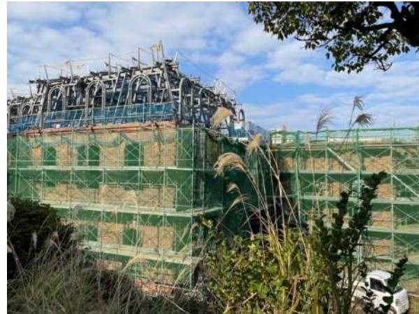
②グラバー通り方向より撮影
