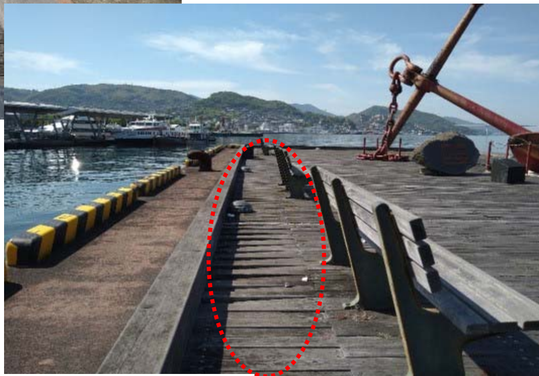
岸壁改良箇所の現況
