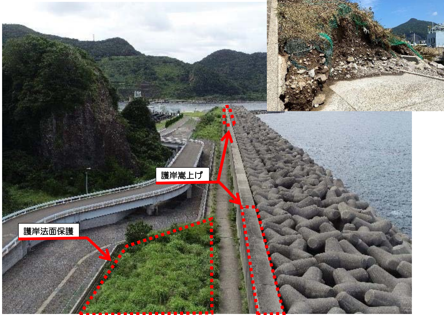
護岸改良箇所の現況
