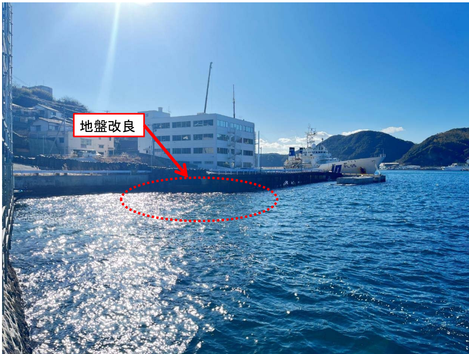
岸壁改良箇所の現況
