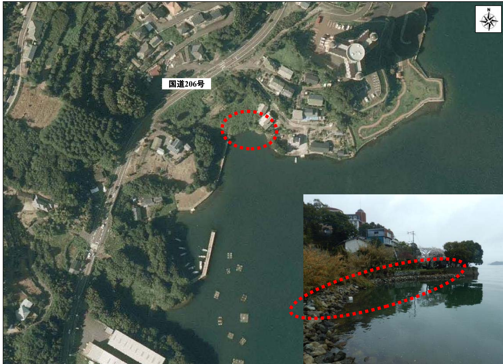
護岸改良箇所の現況
