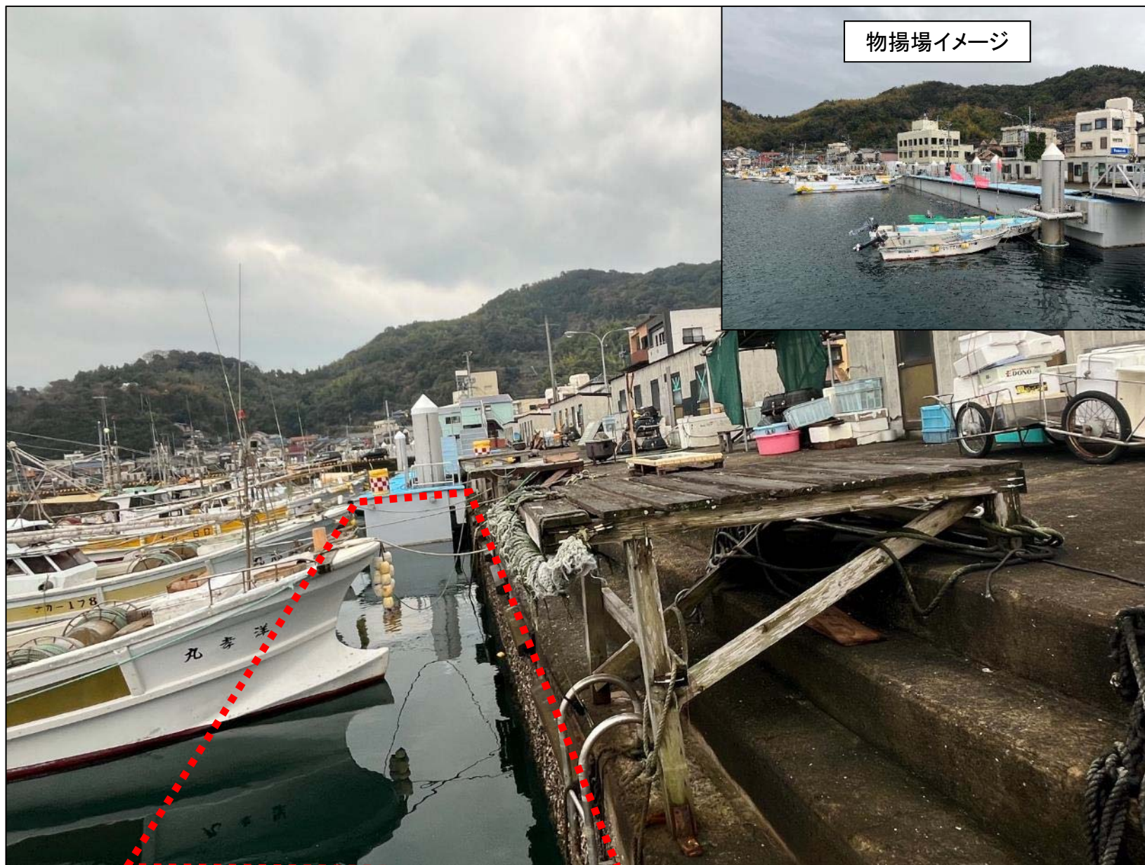
物揚場改良箇所の現況
