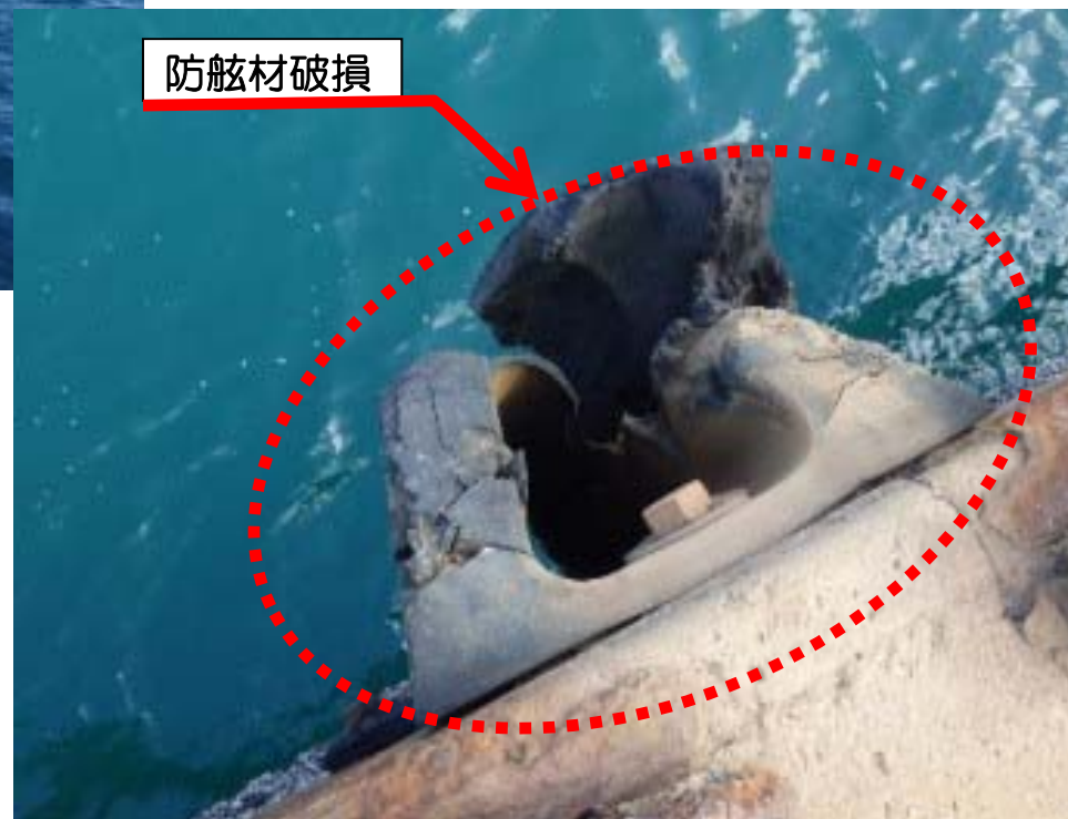
岸壁改良箇所の現況
