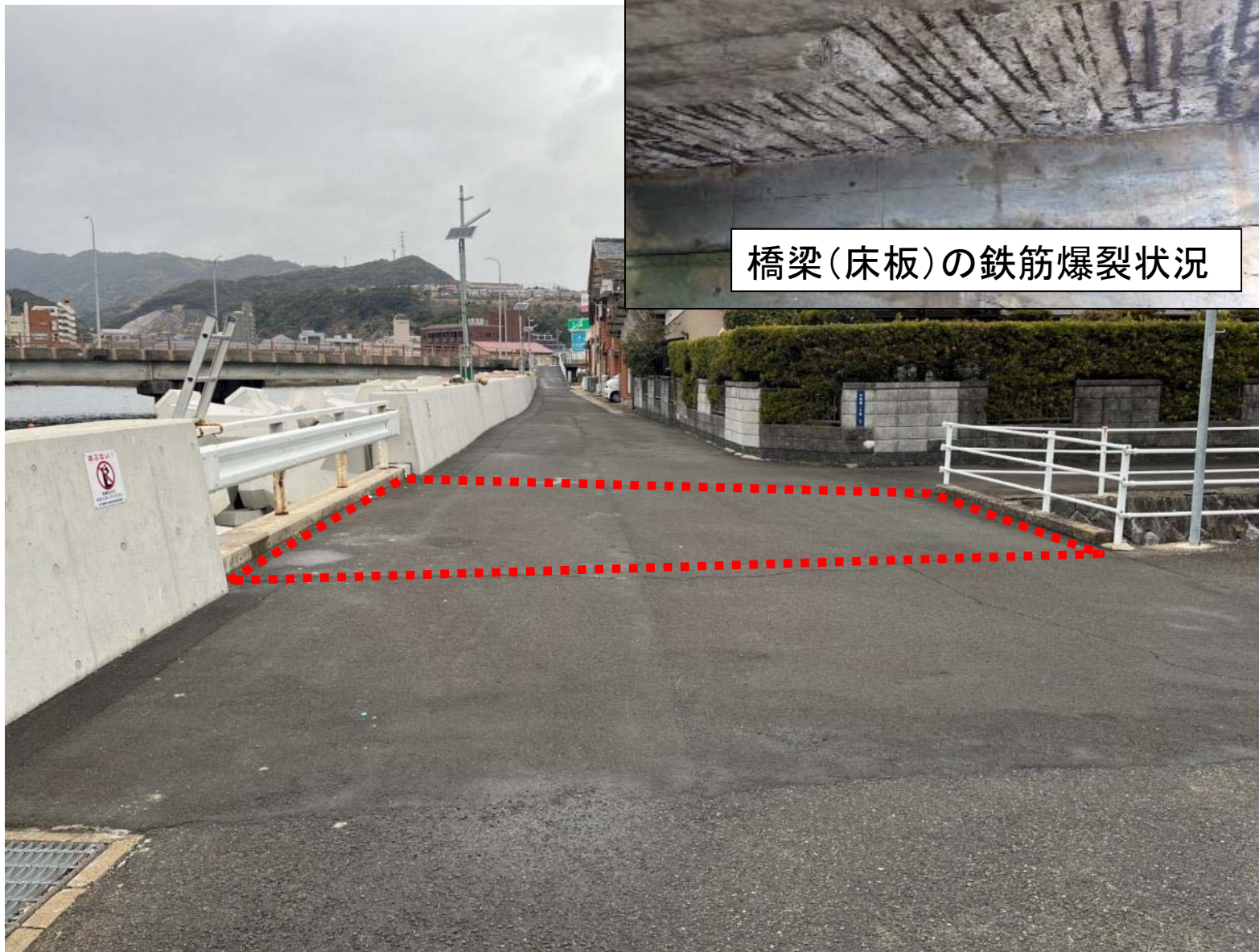
護岸改良箇所の現況
