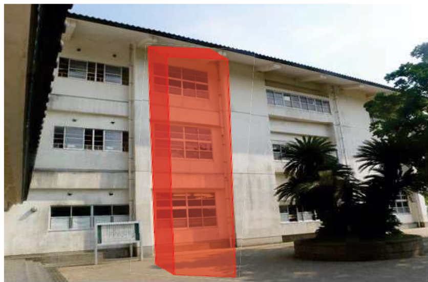
現況（設置予定箇所）
