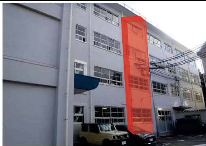
現況（設置予定箇所）
