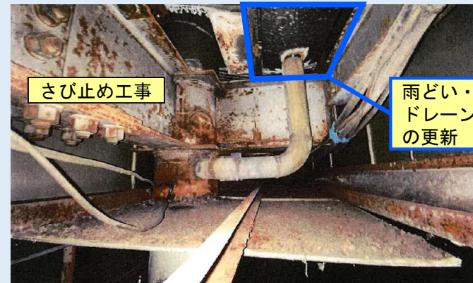
▲外からはわかりづらいが、中を見ると腐食が進んでいる（雨漏りの原因）
