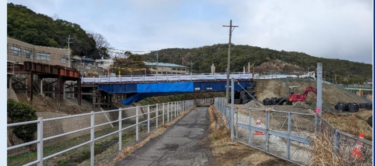
貯水池撤去状況
