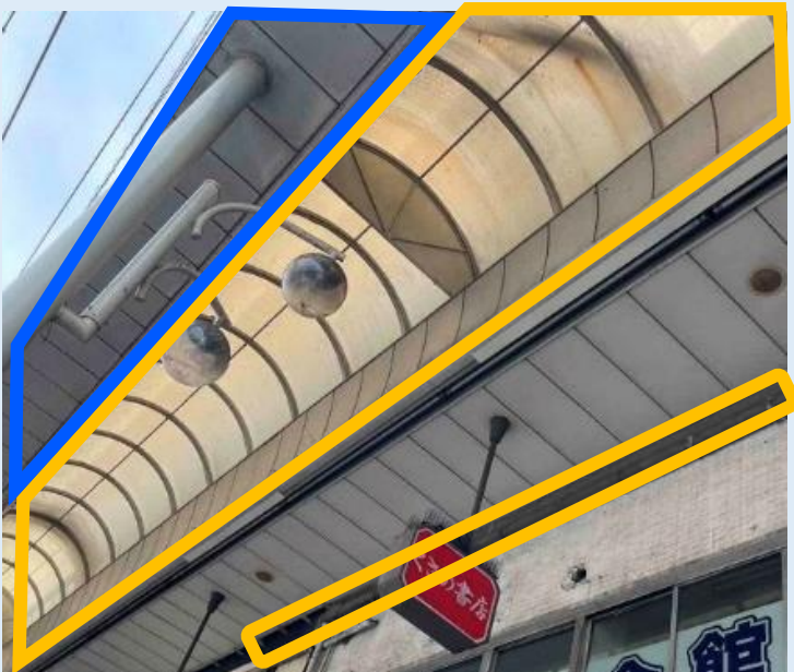
▲ドレインの老朽化による雨漏り。また、防鳥ネットの隙間などから鳩が侵入
