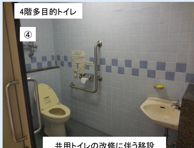
共用トイレの改修に伴う移設
