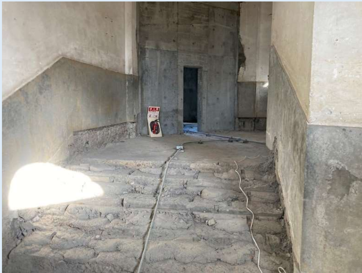
2～3階の階段部（未整備）
