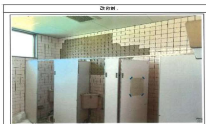
（施工写真）トイレ壁タイル修繕
