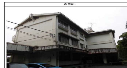
（施工写真）外壁改修工事
