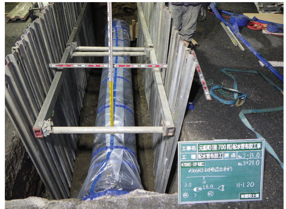
配水管布設完了
