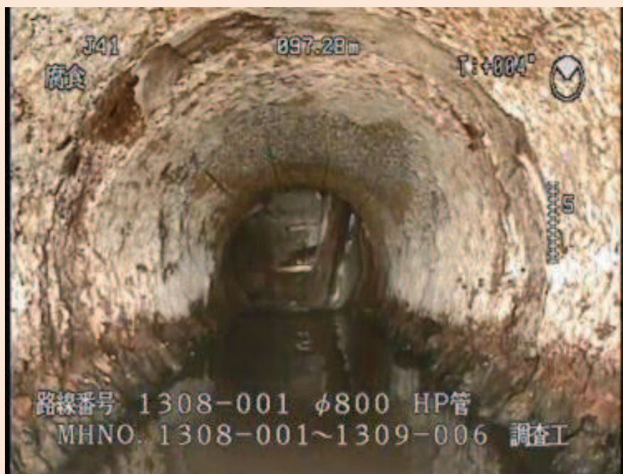
管更生 施工前
