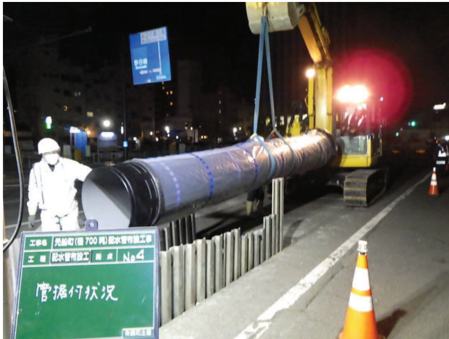
配水管開削布設状況
