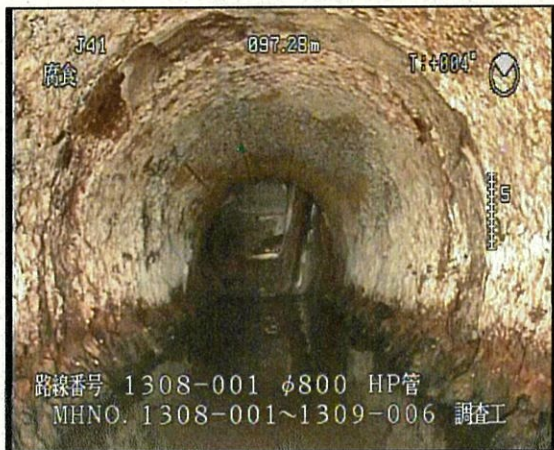
管更生 施工前
