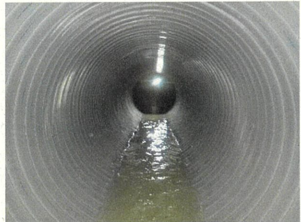
管更生 施工後
