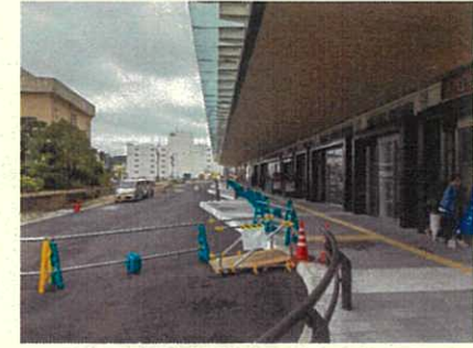
⑥公共交通広場 (仮供用) (令和3年4月)
