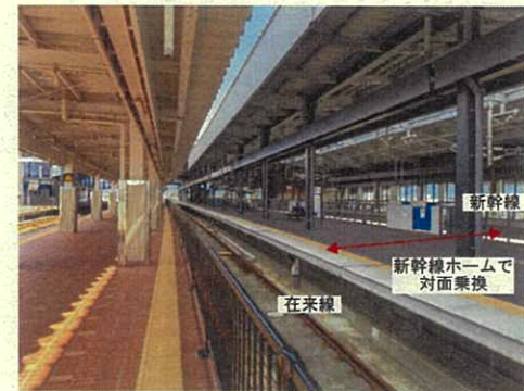
⑧乗換ホーム（令和3年9月）
