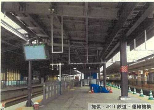
②新幹線ホーム（嬉野方）（令和3年8月）
