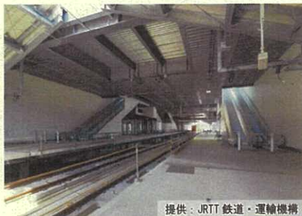
③新幹線ホーム (長崎方) (令和3年8月) 提供: JRTT 鉄道・運輸機構
