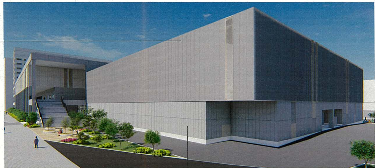
イベント展示ホール南西面を望む
