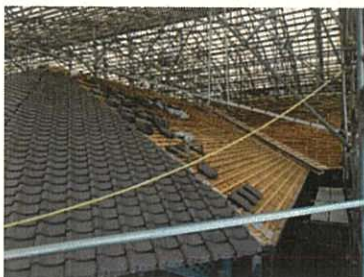
旧グラバー住宅修復工事
