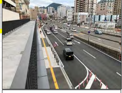
車道の拡幅及び車線運用の見直し
