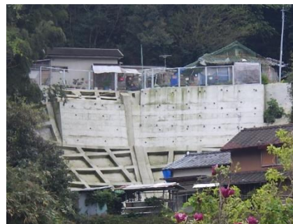
張コンクリート工
