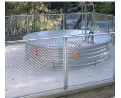
集水井工状況写真
