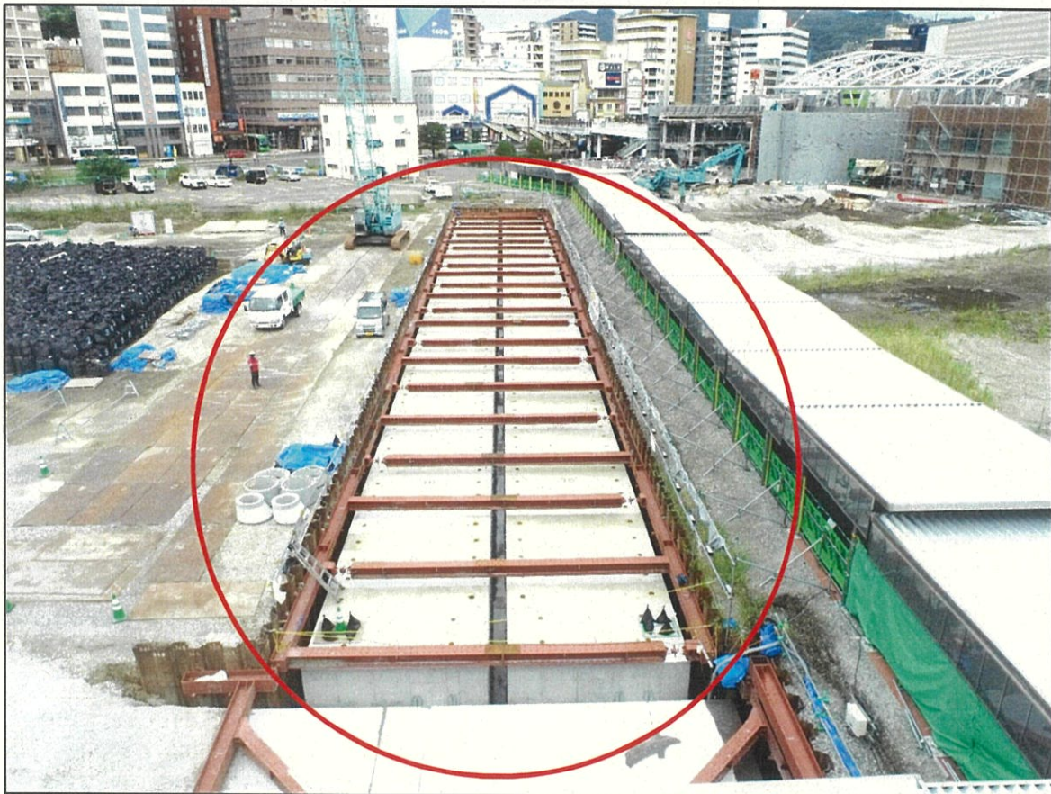
貯留管布設状況写真
