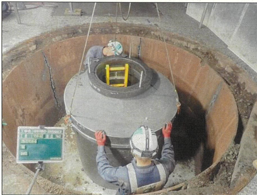
人孔築造状況写真
