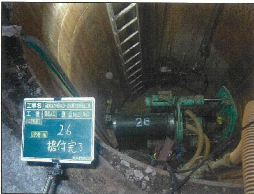
施工（推進工事）状況写真
