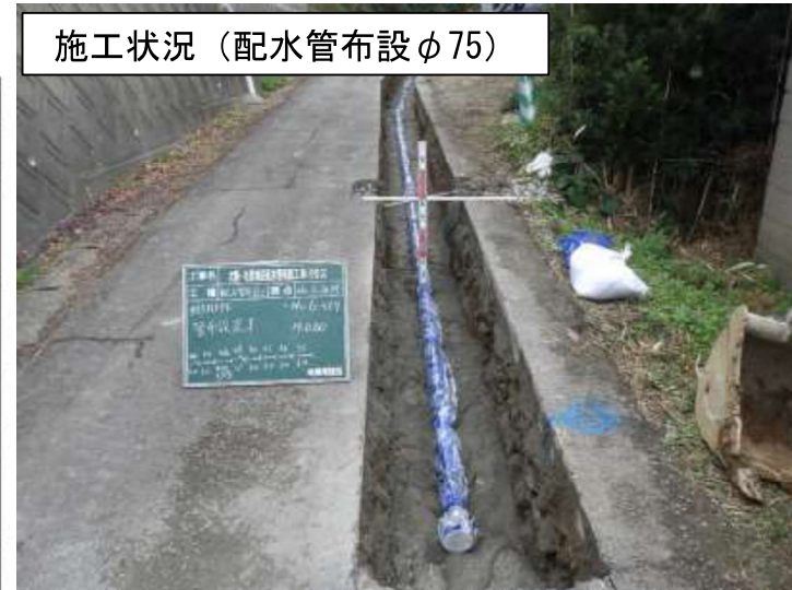
施工状況（配水管布設φ30）
