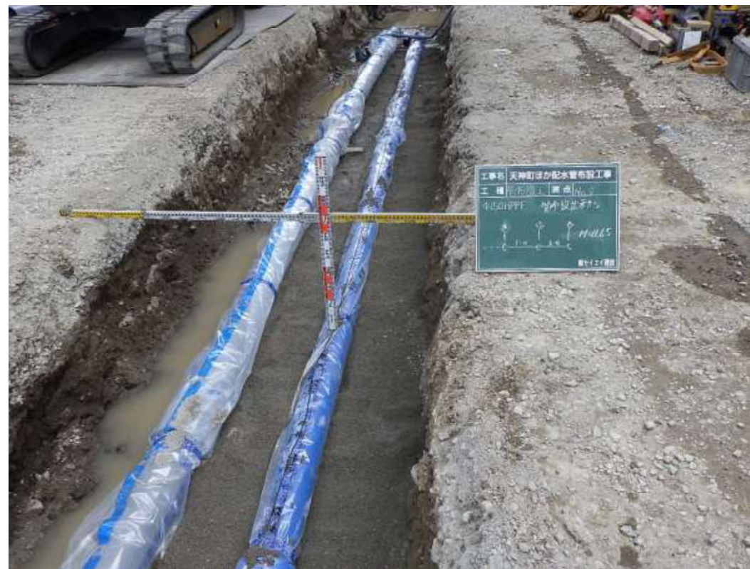
施工状況（配水管布設）
