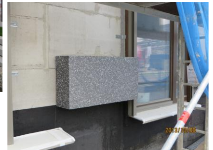
壁の外に貼られた断熱材（発砲スチロール）↓
