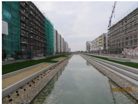
バーンシュタット地区内にある人口水路。屋上に降る雨や雪の一部が流れ込むようになっている。↑
