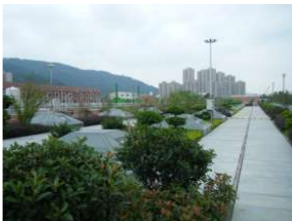
景観に配慮し庭園のように緑化された反応槽の上
