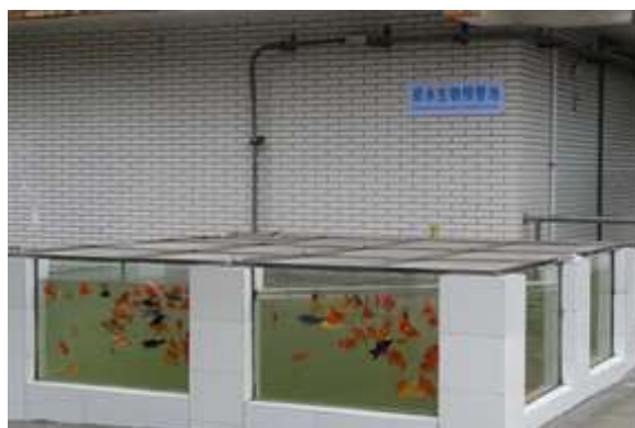
原水に毒性物質が混入した際の早期発見を目的とする「原水生物預警池」(魚類監視設備)
