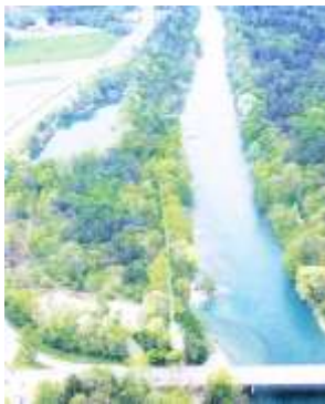
改修途中の写真
