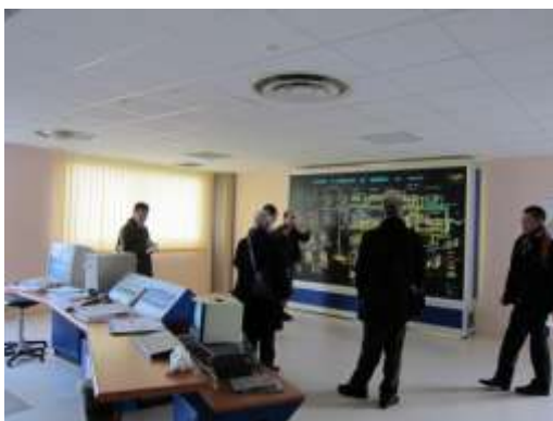
コントロール室
