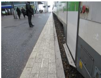
列車の入り口、ホームと同じ高さ
