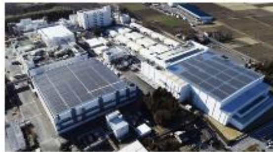
図1 栃木工場の太陽光発電設備（工場棟の屋上の様子）
