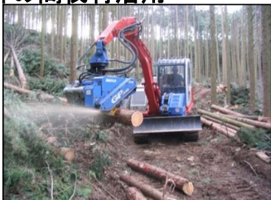
間伐作業（既存補助）山林整備事業
